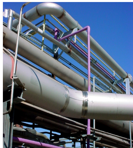
Sistema instalado para hipoclorito en servicio desde 2000.
